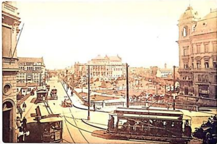
Fotografia do Viaduto do Chá, na cidade de São Paulo (SP), década de 1910.
